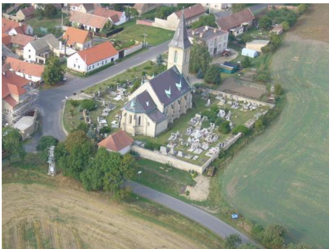
Letecký pohled na kostel a jeho okolí
